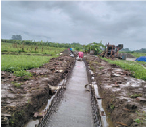
सिचाई कूलो निर्माण-रत्ननगर नपा-चितवन
