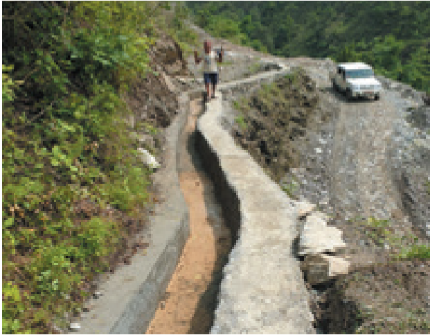
सिचाई कुलो निर्माण-गोलञ्जोर गापा-सिन्धुली
