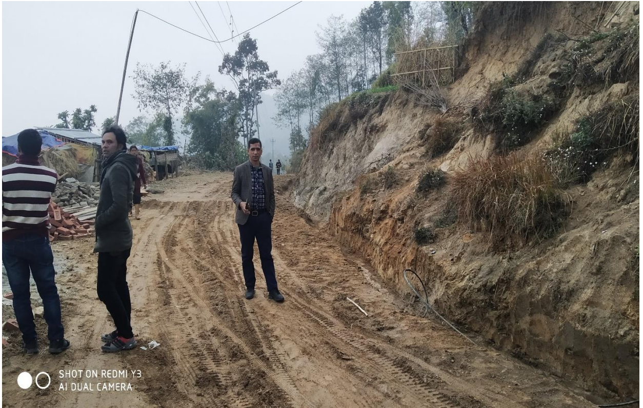
धनकुटाको महालक्ष्मि नगरपालिकामा प्रधानमन्त्री रोजगार कार्यक्रममार्फत निर्मित सडक नाली तथा मर्मत गरिएको सडक ।
